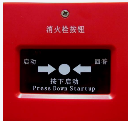
消火栓报警按钮
